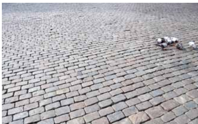
Pavés en granit. Pose traditionnelle jointive en quinconce – Détail (Grand-Place de Bruxelles)
