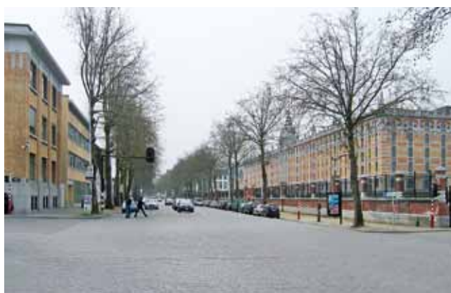
Pavés en porphyre. Pose traditionnelle jointive en quinconce, contreboutée par des bordures en pierre bleue (avenue du Port à Bruxelles, vaste artère industrielle du quartier maritime résistante depuis plus de 100 ans à un important charroi quotidien, mais non entretenue depuis plus de 30 ans)
