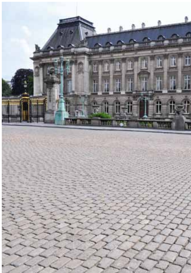
Pavés en granit. Pose traditionnelle jointive en quinconce (place des Palais à Bruxelles – en arrière plan le Palais Royal)
